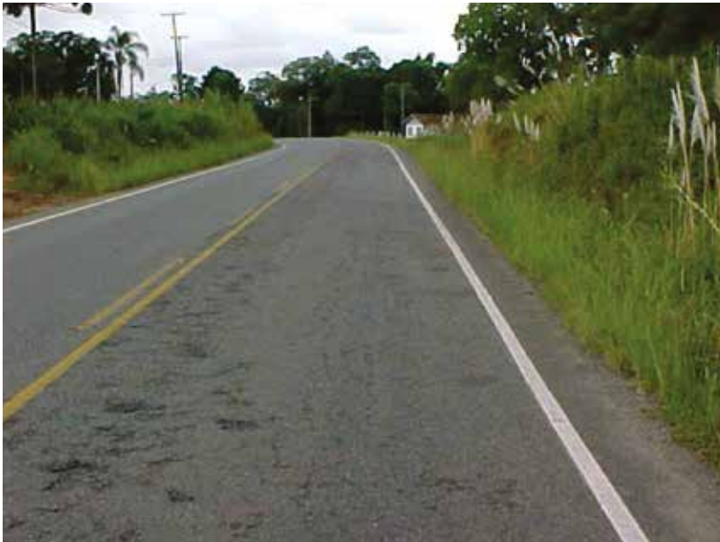
Foto 23 – Estrias do tipo falhas de bico
