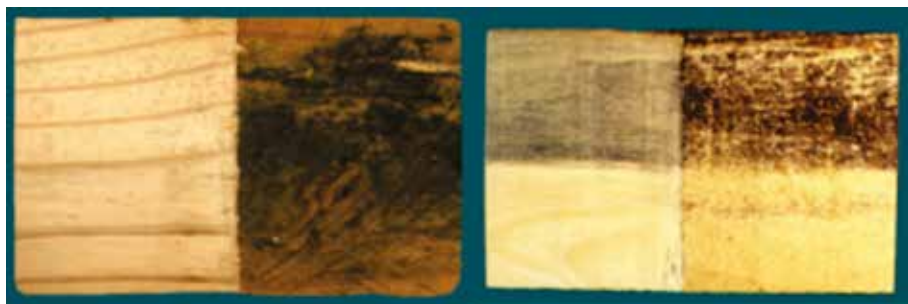
Figura 1 – Fungo embolorador (esquerda) e manchador (direita). Parte das superfícies foram aplainadas para mostrar as manchas irreversíveis causadas pelos fungos manchadores
