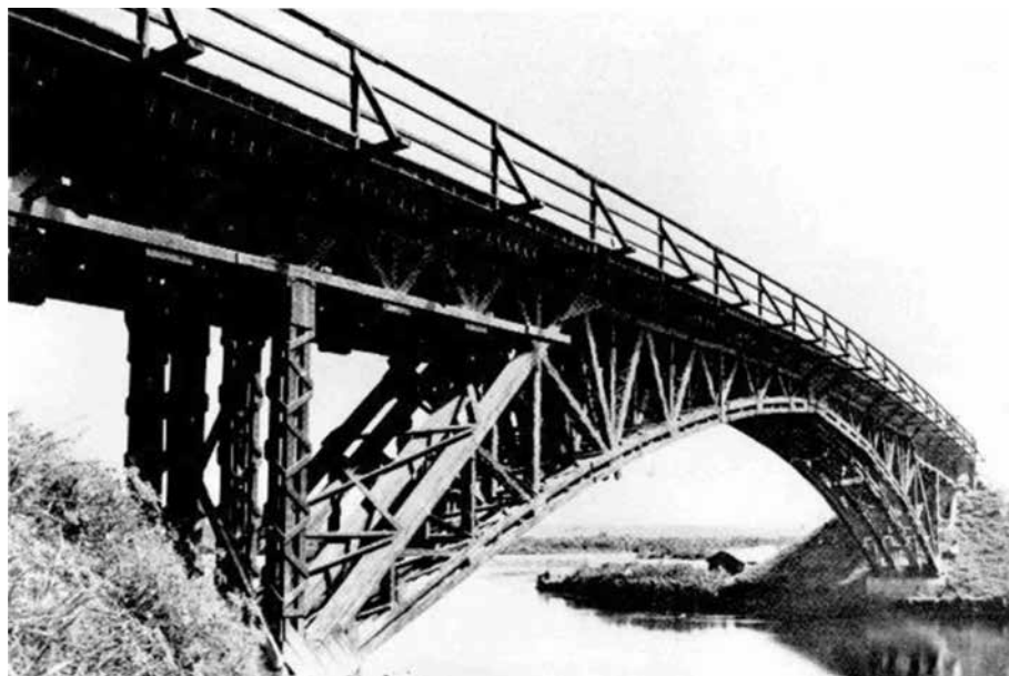
Figura 1 – Ponte sobre o Rio Tietê, 38 m.
