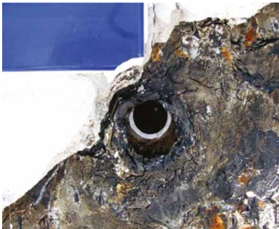
Figura 87 - Detalhe da vedação da manta no tubo
