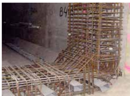
Figura 9 • Ponte recuperada com CAA Fonte: Walraven, 2005
