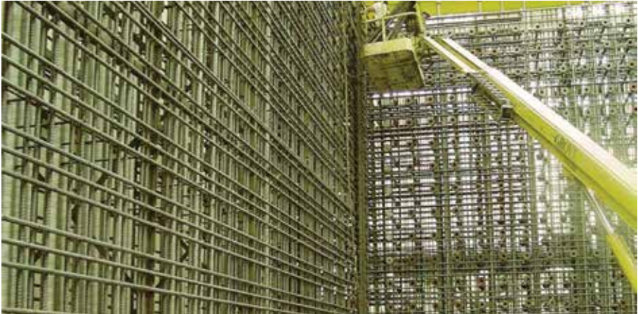
Figura 11 • Parede para simulação de terremotos
