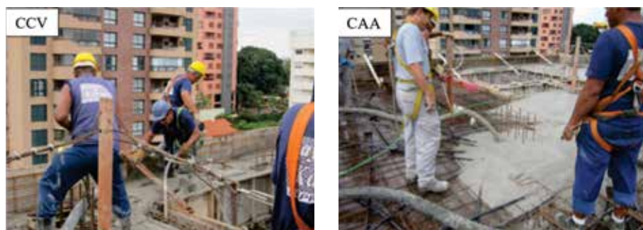
Figura 14 • Concretagem com menos funcionários com o CAA em relação ao CCV Fonte: ?
