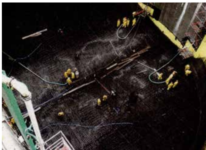
Figura 13 • Alta taxa de armadura de uma laje do metrô de São Paulo concretada com o CAA
