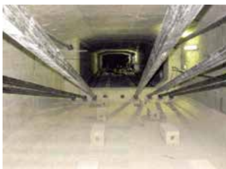
Figura 10 • Vista da armadura da estrutura Fonte: Walraven, 2005
