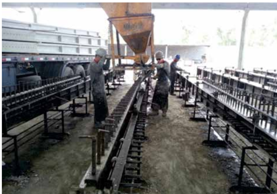
Figura 4 • Postes de concreto com CAA
