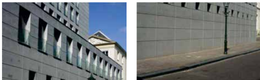
Figura 8 • Fachada em CAA com detalhes arquitetônicos
