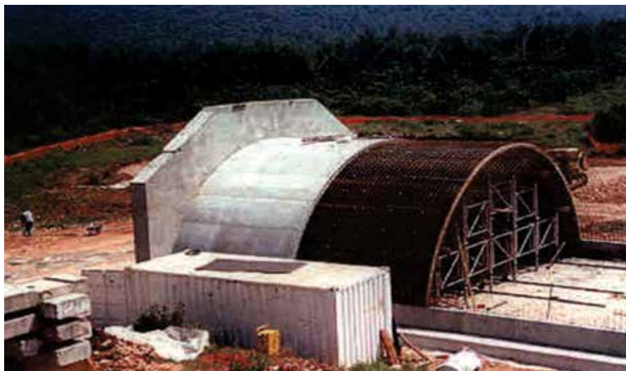
Figura 7 • Estrutura em forma de ‘iglu’, concretada com CAA
