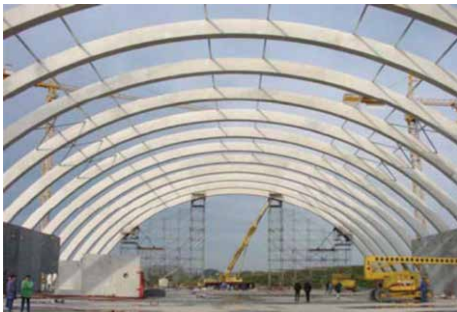
Figura 3 • Arcos compostos por cinco peças executadas em CAA Fonte: Walraven, 2005
