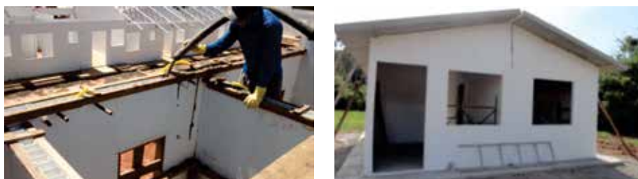
Figura 16 • Edificação em parede de concreto autoadensável sendo executada Fonte: Acervo de Bernardo Tutikian
